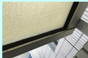
ガラスビート（パッキン）交換
