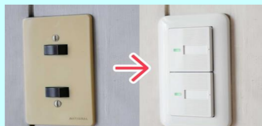
スイッチ取替・修理
